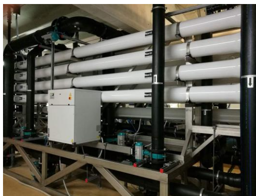
Slika 11: Modulni sistem UF naprave
